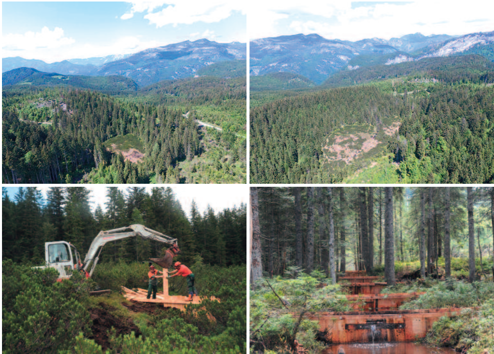
Abb. 1: Rosstallmoos (oben links) und Langmoos (oben rechts) aus der Vogelperspektive; Einbau der Spundwände im Latschenfilz (unten links) und Spundwandkaskade im Moorrandwald des Langmooses (unten rechts). Fotos: G. Fischer
