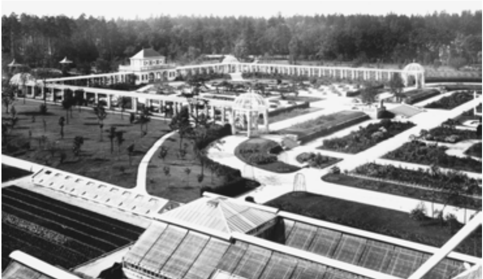
Abb. 3: Luftaufnahme der Pergola des Botanischen Gartens ca. 1919 mit dem ursprünglich als Trinkhalle angelegten späteren Café. Die geschnitzten Ananas-Skulpturen auf den vier Pergola-Dächern, die viele Jahre fehlten, wurden 2014 historisch getreu erneuert.
